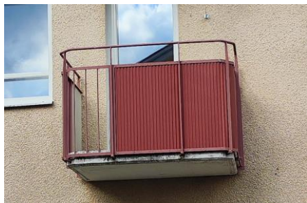
Balkong med räcke.
